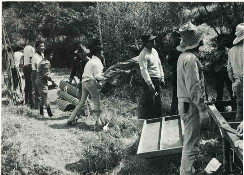
スカウトロッジ建設に汗を流すスカウト・父兄▼
